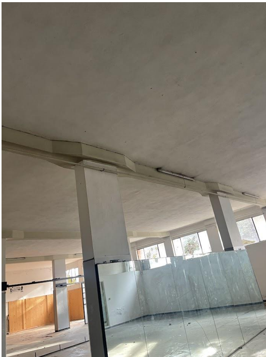
Foto 4 – trave ribassata primo solaio
