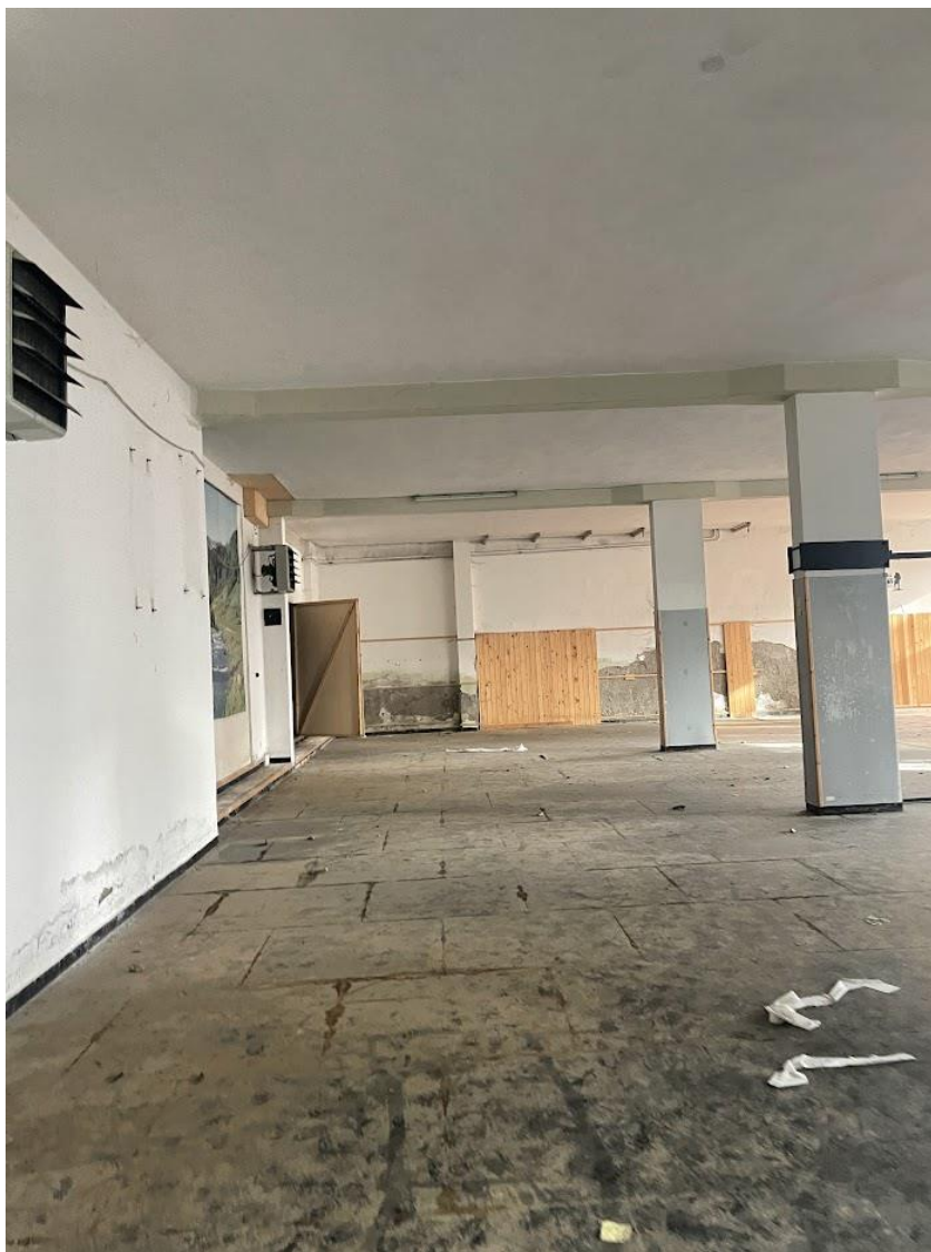
Foto 3 – pilastri in c.a. e pareti al piano seminterrato
